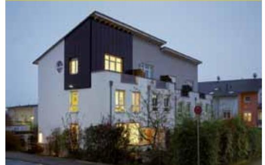
Bei der Fassadensanierung mit Photovoltaik-Modulen (Bosch Solar CISTech) als Verkleidungswerkstoff wurden die für Fassadenkonstruktionen geltenden baurechtlichen Vorgaben bereits bei der Konzeptfindung berücksichtigt und auf Grundlage der zu beachtenden Normen ein Konstruktionsprinzip für den Fassadenaufbau gewählt, welches ohne die Notwendigkeit einer oftmals kostenintensiven Zulassung im Einzelfall ausführbar ist (Gladis Architekten).
