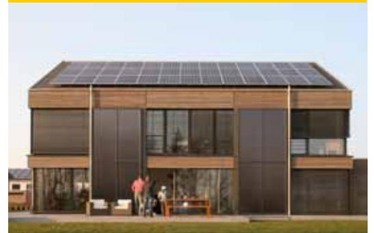
Der große solarthermische Kollektor (24 m<sup>2</sup>) ist in die Südfassade integriert, die Neigung ist damit ideal für die Heizungsunterstützung im Winter. Auf dem Dach ist eine PV-Anlage mit 7 kW installierter Leistung (Schaller + Sternagel Architekten).
