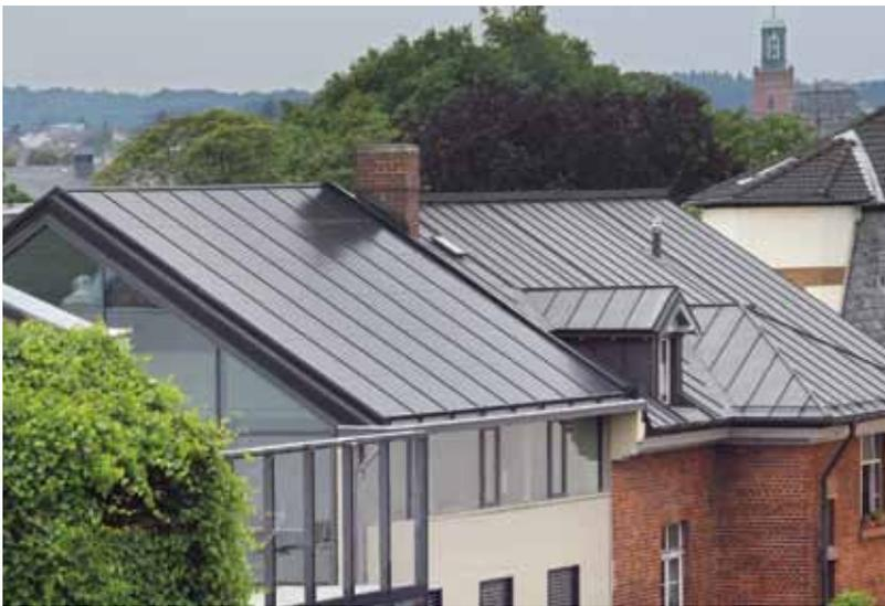
opusHouse (opus Architekten): Die PV-Module sind den umgebenden Dachflächen angepasst.
