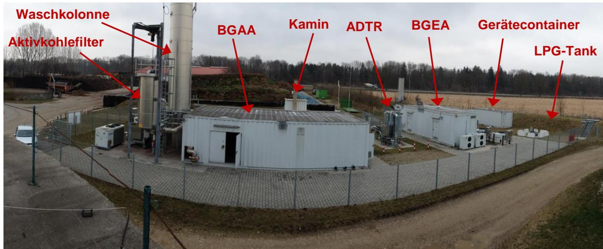
Abbildung 3.6: Biogasaufbereitungs- und Einspeiseanlage der SWM
