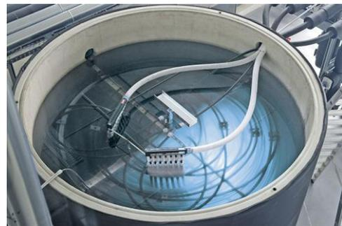
Abbildung 2.12: Blick in einen geöffneten Eisspeicher von Viessmann (Bruschke-Reimer, 2015)
