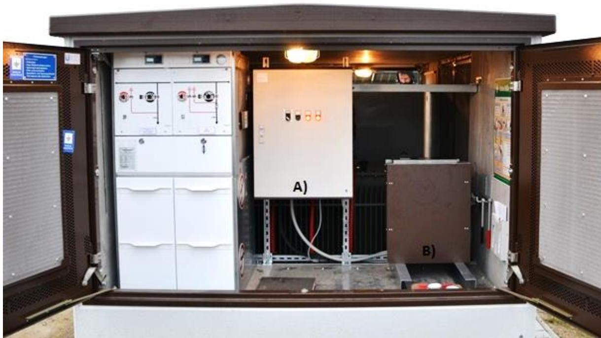
Abbildung 6: Transformatorstation einer 4 MWp PV-Anlage inklusive 50 kVAr-Kompensationsdrossel mit korrespondierender Ansteuerung. A) Steuerschrank; B) Kompensationsdrossel
