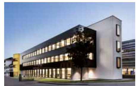
Scheme 112: Stühlingen (D), Büro- und Empfangsgebäude (2016) Applicant: Sto, Stühlingen
