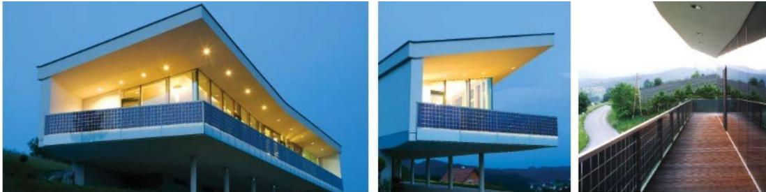
**Abbildung 34: Balkonintegrierte PV**
