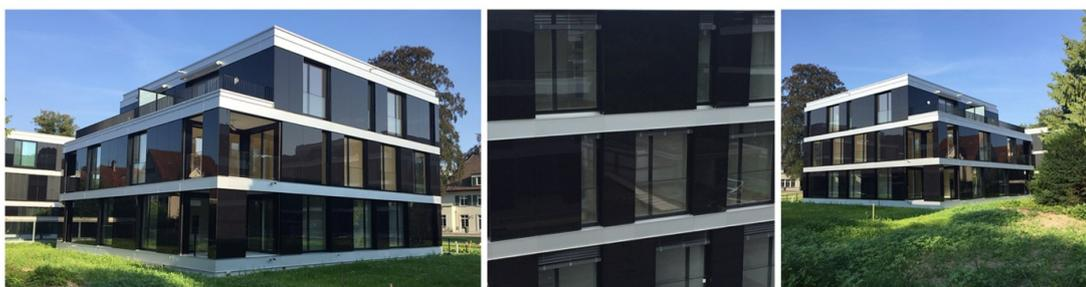
Abbildung 33: Wohnhaus - Fassadenintegrierte PV
