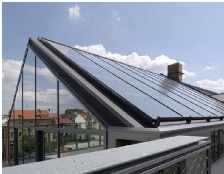
**Abbildung 32: Dachintegrierte PV- + Solarthermieanlage**
