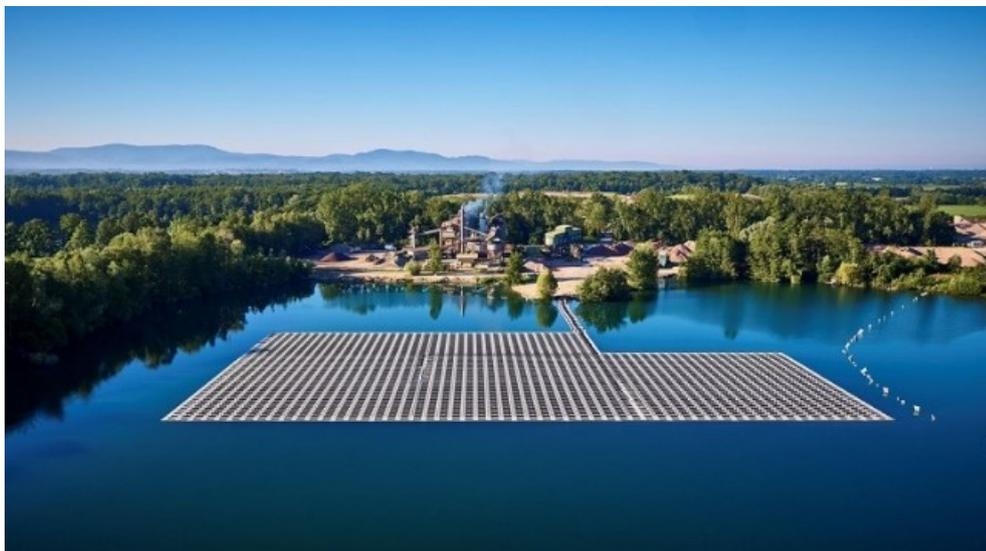
**Abbildung 18: Größte schwimmende PV Deutschlands, Kieswerk Ossola, Renchen – Installation auf Baggersee (750kWp)**
