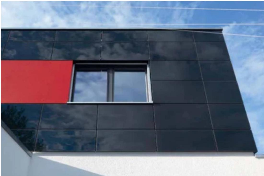
**Abbildung 7: PV-Module in hinterlüfteter Fassade**
