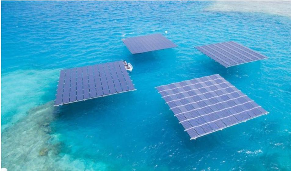
**Abbildung 17: Swimsol PV-Anlage auf den Malediven; Installation auf dem Meer (96 kWp)**
