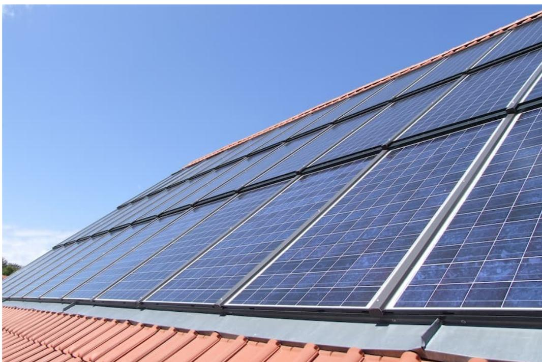
**Abbildung 9: Indach-Photovoltaikanlage**
