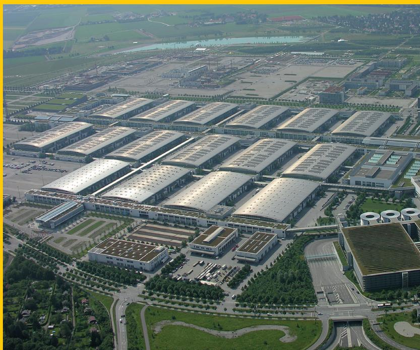
Solardach Messe München, 1 MW PV-Anlage auf den 6 mittleren Hallen (B-Hallen) der Messe München
