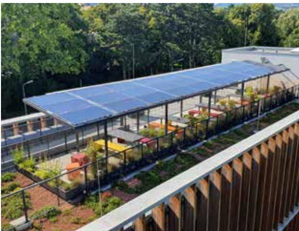
**Abb. 10:** PV-Dachgarten (8 kW) auf dem Türkenwirtgebäude (2018) der Universität für Bodenkultur Wien (Architekt: Baumschlagler Hutter ZT GmbH; Foto: Roman Smutny)
