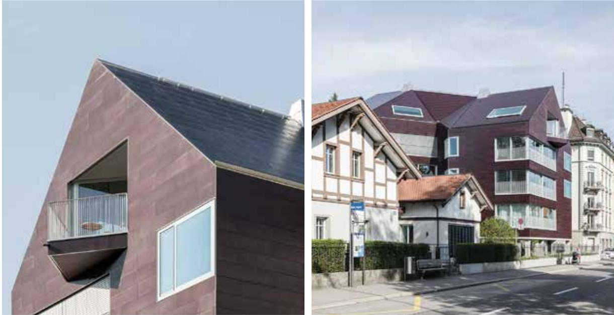
**Abb. 18/19:** Fassade und Dach am Wohnhaus Solaris (2017) in Zürich sind als Solargenerator ausgebildet (huggenbergerfries Architekten AG, Ertex Solartechnik GmbH – Einreicher; Fotos: Beat Bühler).
