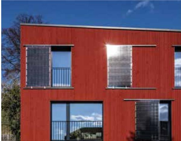
**Abb. 39:** Mehrfamilienhaus, Küsnacht, mit 24,6 kW PV-Leistung in Fassade und Dach (Architektur: Vera Gloor AG; Foto: Aladin Klieber)
