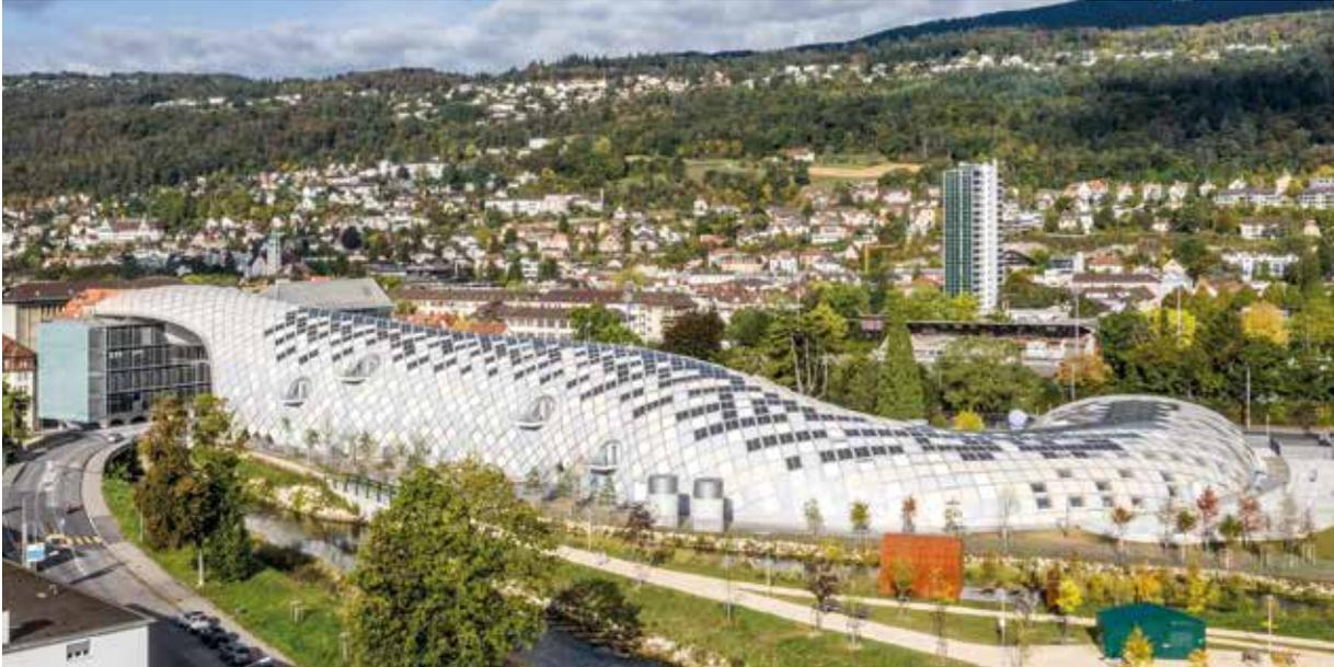
**Abb. 9:** 442 der insgesamt rd. 2.800 Wabenelemente der gewölbten Fassade des Swatch Headquarters (2019) in Biel von Shigeru Ban Architects, lokaler Architekt Itten + Brechbühl AG, sind mit PV-Zellen (250 kW) belegt (Foto: Swatch).
