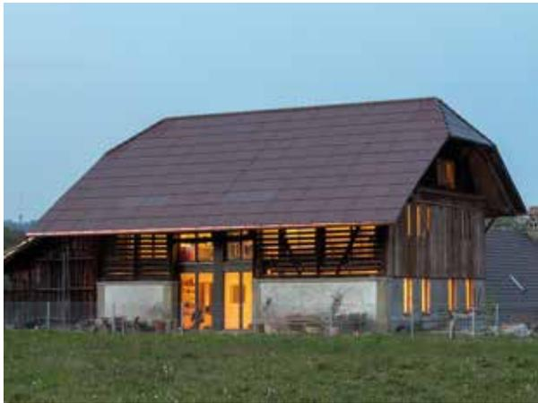
**Abb. 14:** 38 kW PV-Anlage (2019) auf dem Hauptgebäude des Bauerngutes Weyerquet, Wabern (Halle58 Architekten)
