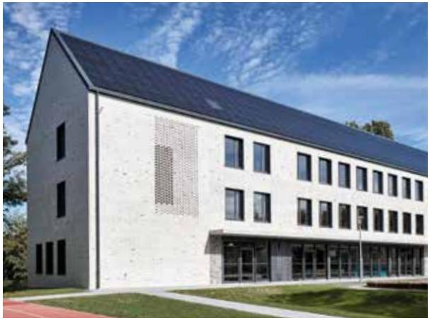
**Abb. 15:** PV-Anlage (70 kW) auf der Erweiterung der Pestalozzischule (2018) in Freiburg (Architekten: Spiecker Sautter Lauer; Foto: Miguel Babo)
