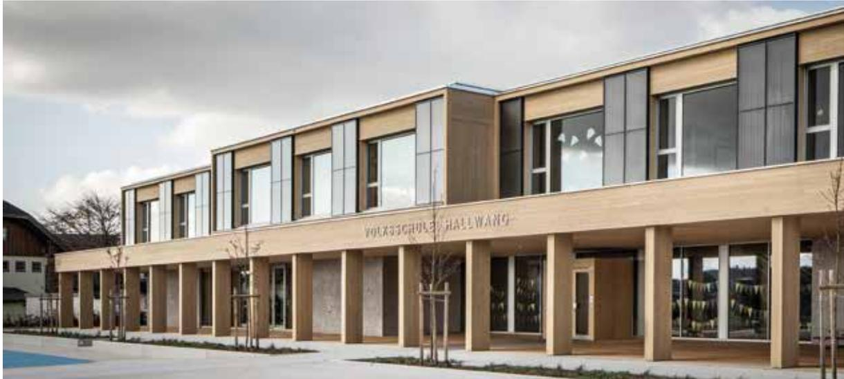
**Abb. 41:** 100 m<sup>2</sup> Solarthermie-Fassade an der Volksschule Hallwang (2017). Auf dem Flachdach sind zusätzlich noch 20,5 kW PV aufgeständert sowie 180 m<sup>2</sup> Solarthermie-Kollektoren. (LP architektur ZT GmbH; Foto: Albrecht Imanuel Schnabel)
