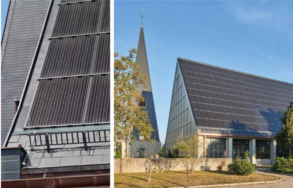
**Abb. 22/23:** Sanierung (2018) mit 78,4 kW Solardach an der Kirche St. Wunibald in Georgensgmünd (Ing.-Büro Johannes Wunram; Fotos: Solarwatt).
