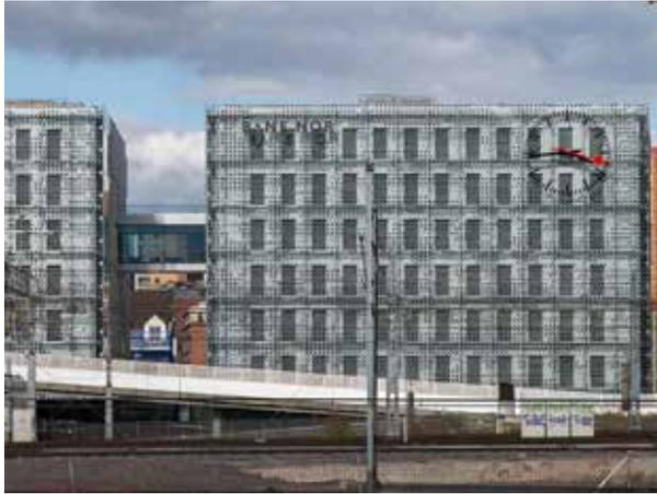
**Abb. 12:** PV-Fassade (48,59 kW) am Bürogebäude Bane Nor (2020) in Oslo (LPO Arkitekter)
