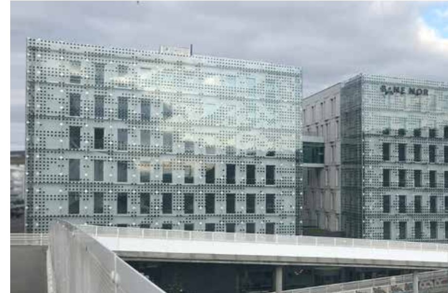
Abb. 7/8: Der Anteil reiner PV-Anlagen nimmt im Laufe der Jahre kontinuierlich zu und umfasst 2020 über 80 % der Einreichungen. Projektbeispiel: PV-Fassade (48,59 kW) am Bürogebäude Bane Nor (2020) in Oslo (LPO Arkitekter).
