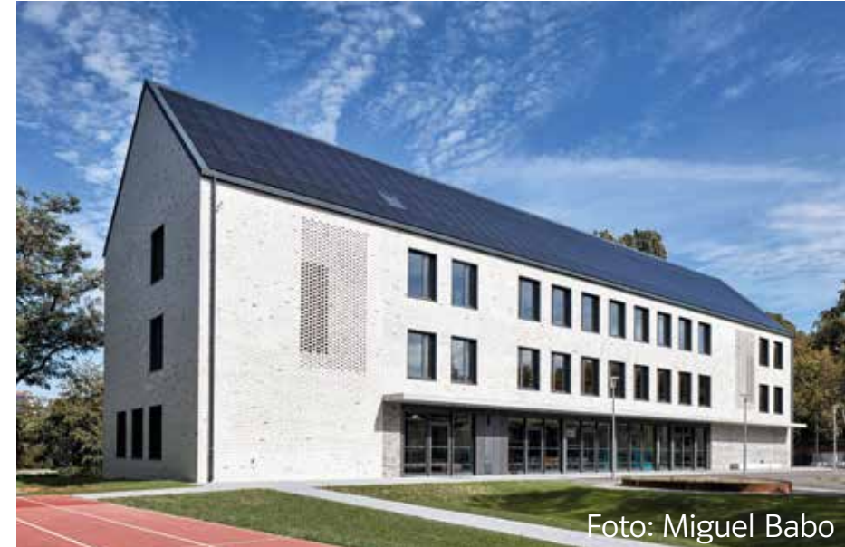
Abb. 3/4: Projektstandorte in 26 Ländern sind ebenfalls Rekord, auch wenn weiterhin die Einreichungen aus dem D-A-CH-Raum dominieren. Projektbeispiel: PV-Anlage (70 kW) auf der Erweiterung der Pestalozzischule (2018) in Freiburg (Architekten: Spiecker Sautter Lauer).
