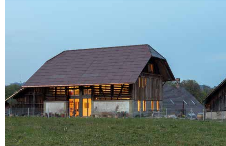
Abb. 5/6: Wohnungsbauten machen etwas mehr als die Hälfte der Einreichungen aus. Die überwiegende Zahl sind Neubauten, nur 16 % der Einreichungen sind Bestandsanierungen. Projektbeispiel: 38 kW PV-Anlage Weyerguet (2019), Wabern (Halle58 Architekten).
