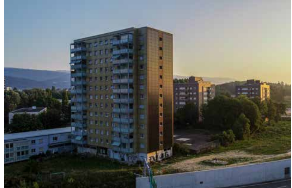
Abb. 1/2: Mit 159 Projekten wurde ein Höchststand bei den Einreichungen erzielt. Projektbeispiel: PV-Fassade (44,46 kW) bei einer Sanierung (2019) am Wohnhochhaus Aegertenstrasse in Biel (Architekt: Reto Bertolotti), PV-Module: 3S Solar Plus AG (Einreicher).
