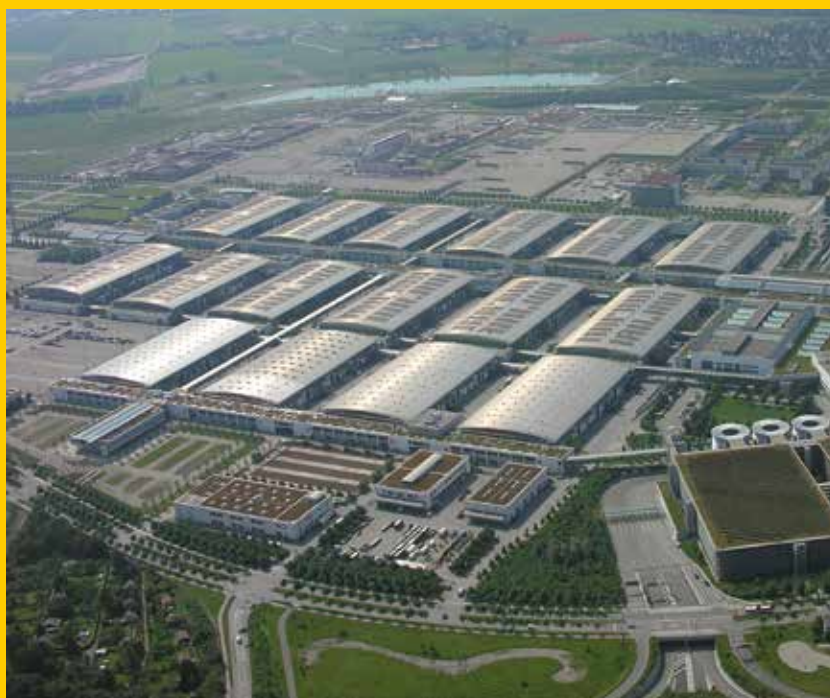
Soldach Messe München, 1 MW PV-Anlage auf den 6 mittleren Hallen (B-Hallen) der Messe München (Foto: Messe München International)
