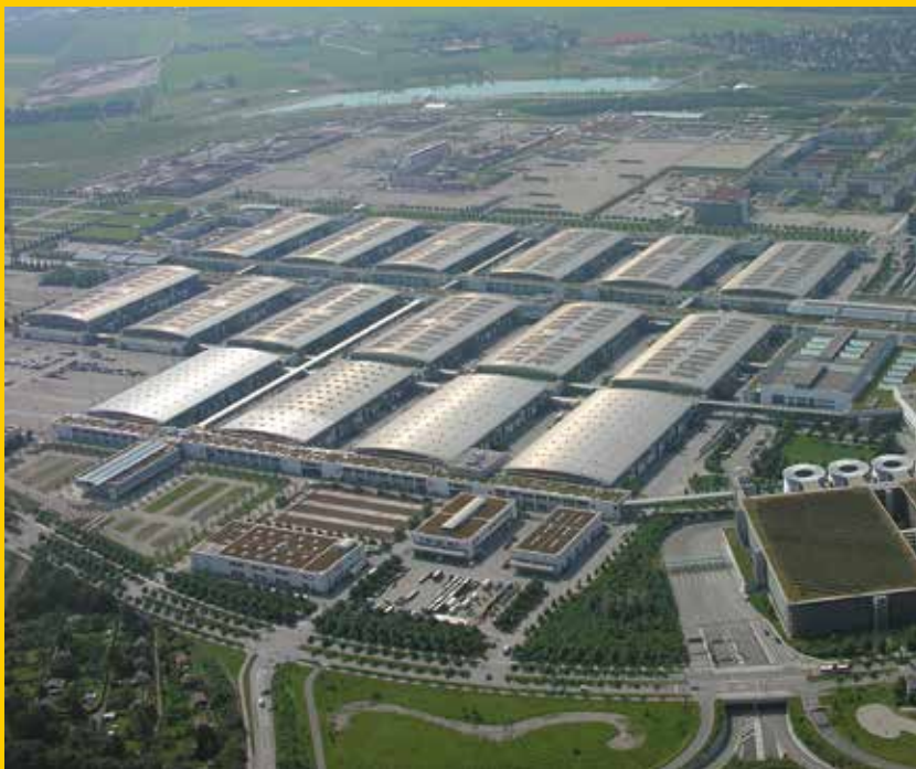
Solardach Messe München, 1 MW PV-Anlage auf den 6 mittleren Hallen (B-Hallen) der Messe München (Foto: Messe München International)
