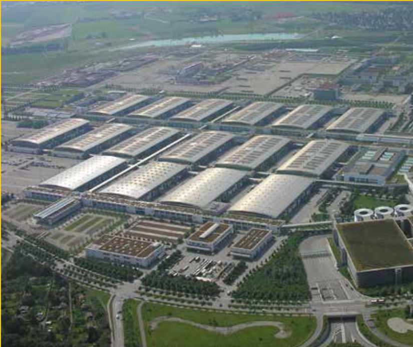
Soldach Messe München, 1 MW PV-Anlage auf den 6 mittleren Hallen (B-Hallen) der Messe München (Foto: Messe München International)
