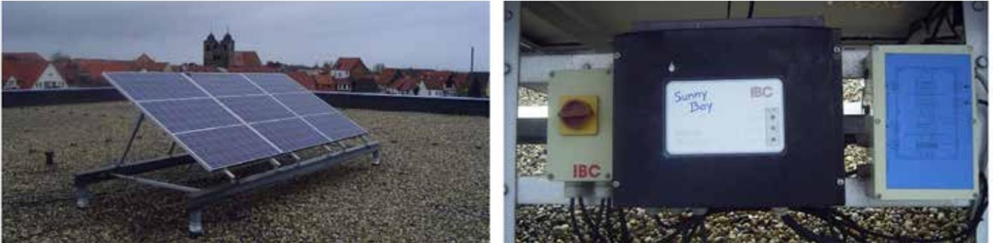
Abb. 5: Solargenerator und Wechselrichter: Berufsschule, Oschersleben
