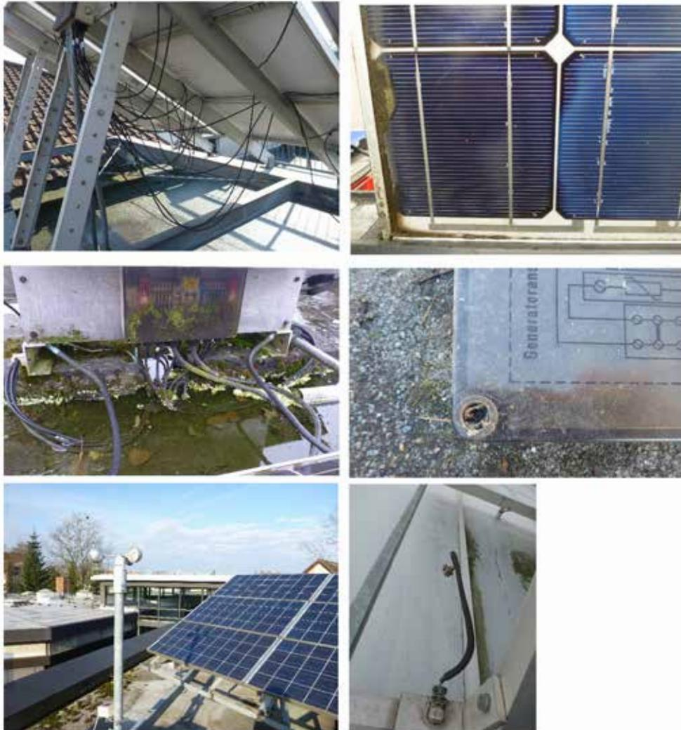
**Abb. 22:** Bei der Sichtprüfung entdeckte Fehler (von links nach rechts, von oben nach unten): Unübersichtliche Verkabelung in Würzburg / Flechten- und Pflanzenrückstände eines Moduls in Bayreuth / Kabelführung im Wasser in Coburg / Verschleiß des Verschlusses einer Generatoranschlussdose in Coburg / Verschattung der Module durch Windmessung in Braunschweig / Erdungskabel nicht ordnungsgemäß angebracht in Kassel
