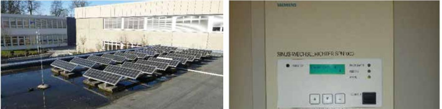
Abb. 3: Solargenerator und Wechselrichter: Regiomontanus Schule, Coburg
