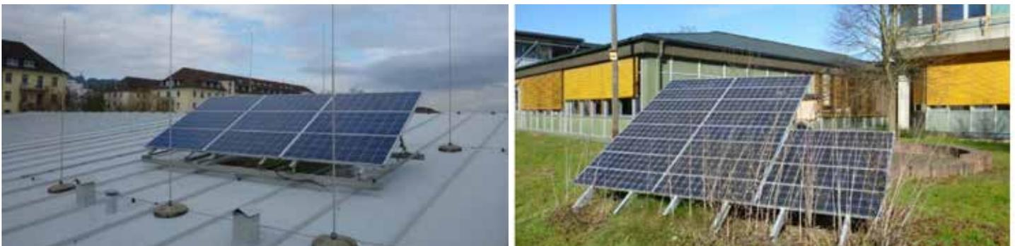
Abb. 19: Beispiele für Verschattung – durch Blitzschutzstangen in Kassel, durch Gebüsch in Forchheim
