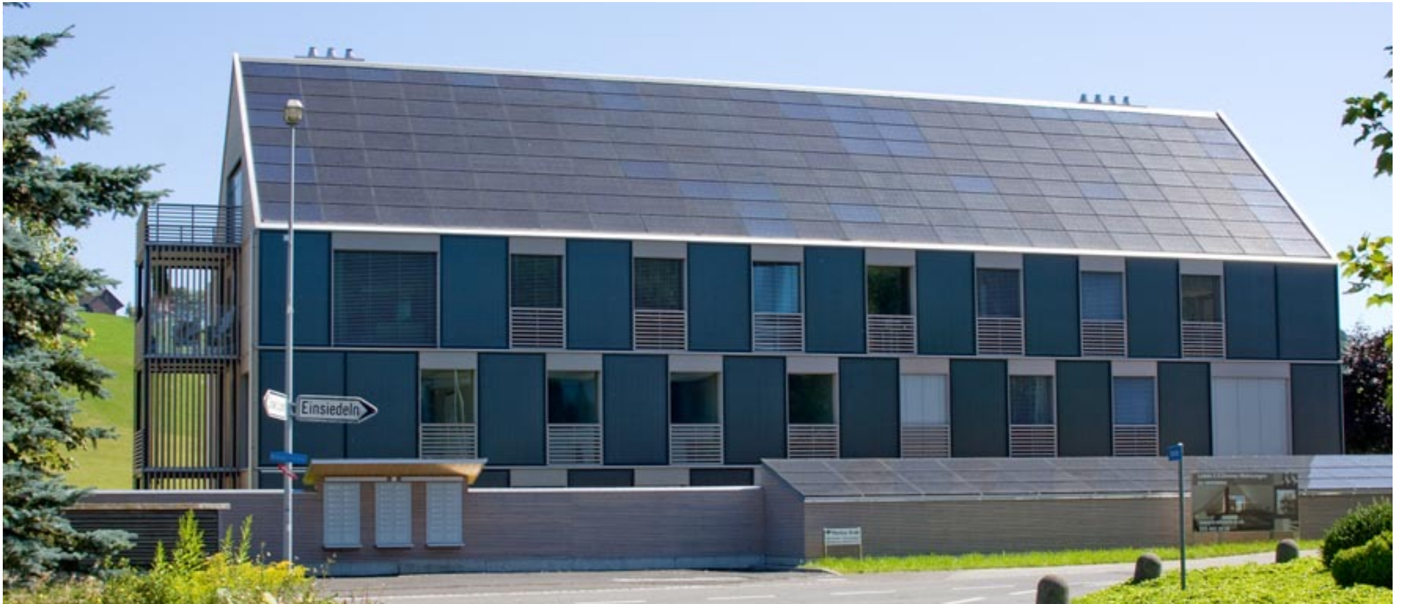
Kraftwerk B, Bennau
